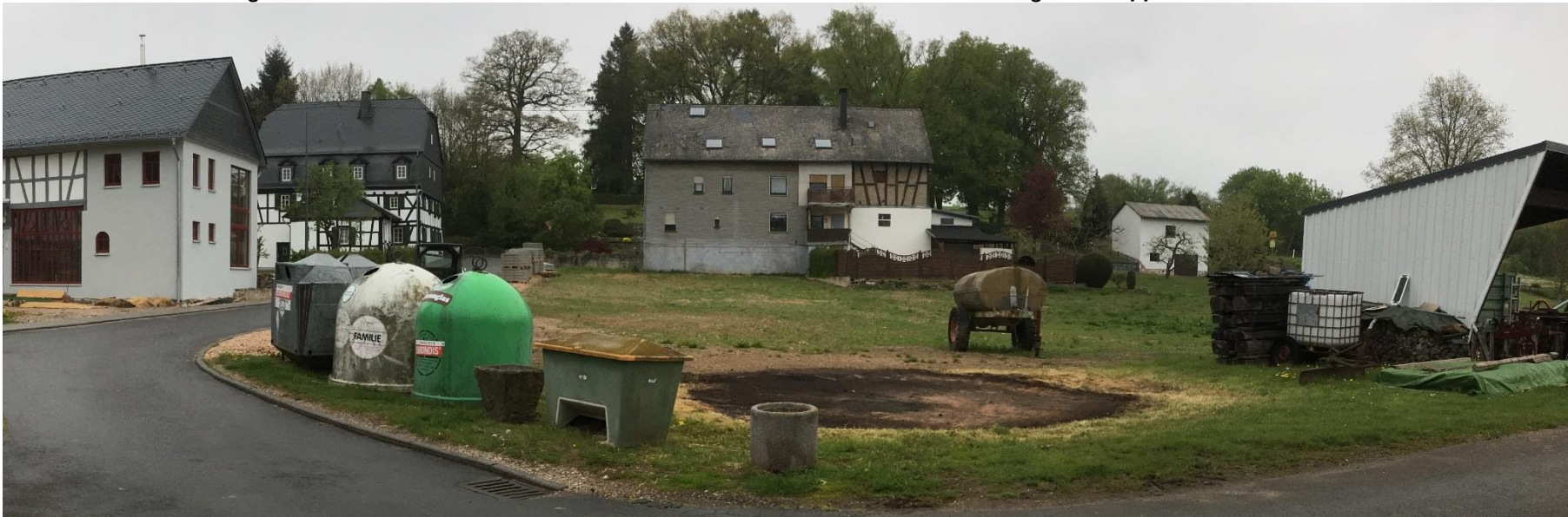
Panorama, Blickrichtung Norden, zentral die Flächen nach dem Abriss mit Sammelstelle Altglas und Streugut, rechts Bauhofsschuppen
